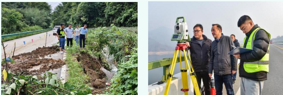
图 3-13 武余波老师指导金寨公路交通抗洪救灾和金寨县金桃大桥荷载试验检测
